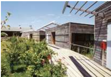
Gîte pour groupe de la maison de la nature du bassin d'Arcachon au parc ornithologique du Teich (PNR des Landes de Gascogne, 33)
